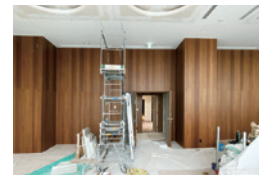
四つ星ホテルの内装工事の様子
